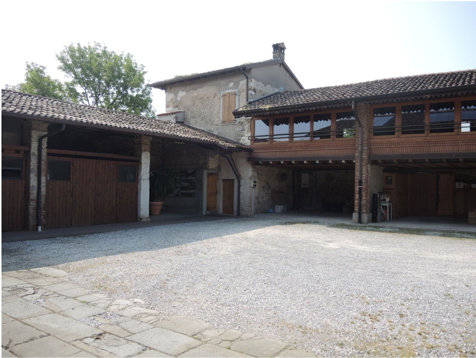
Vista interna da Nord-Ovest
