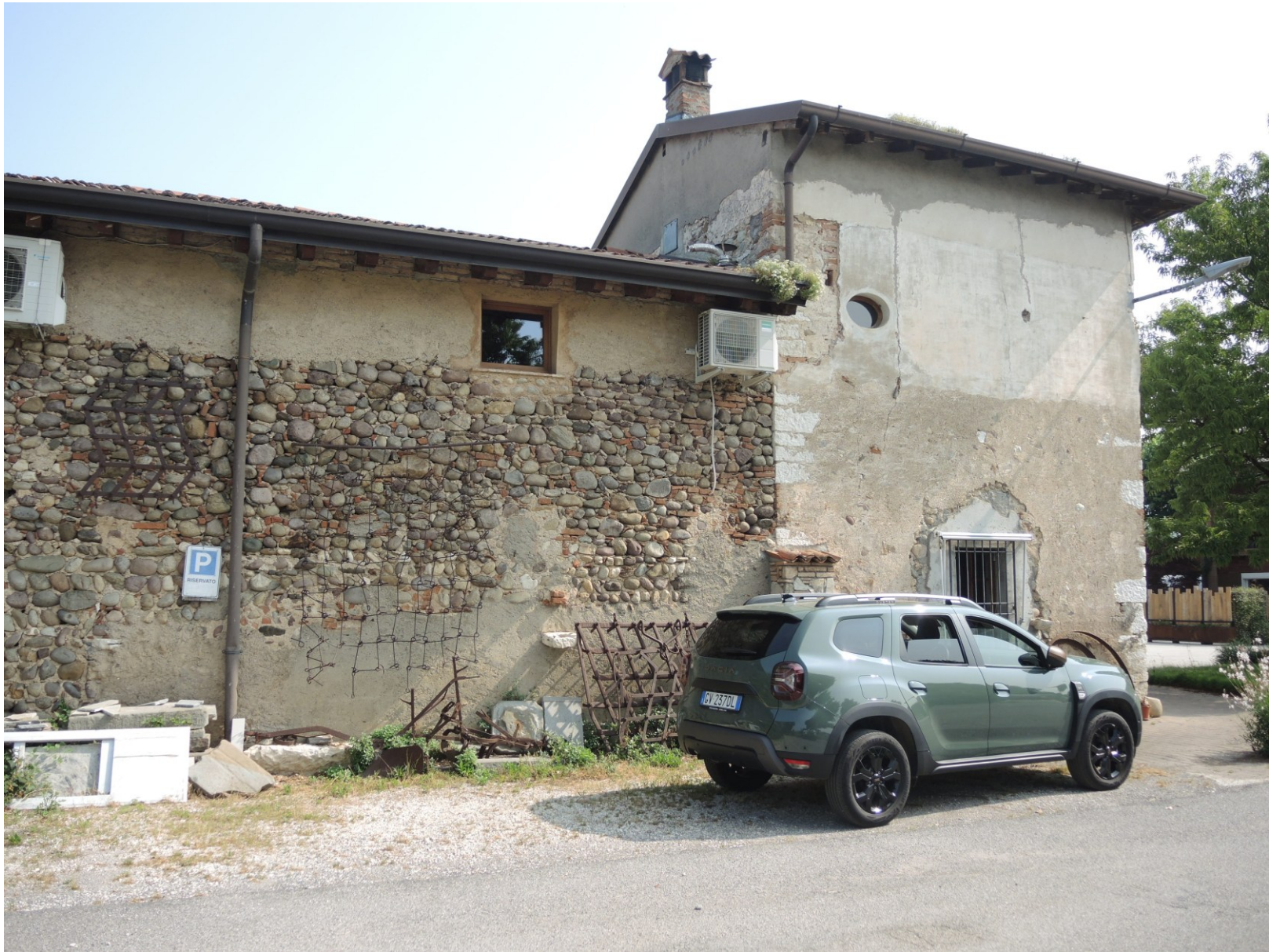
Vista da sud – SITUAZIONE ESISTENTE
